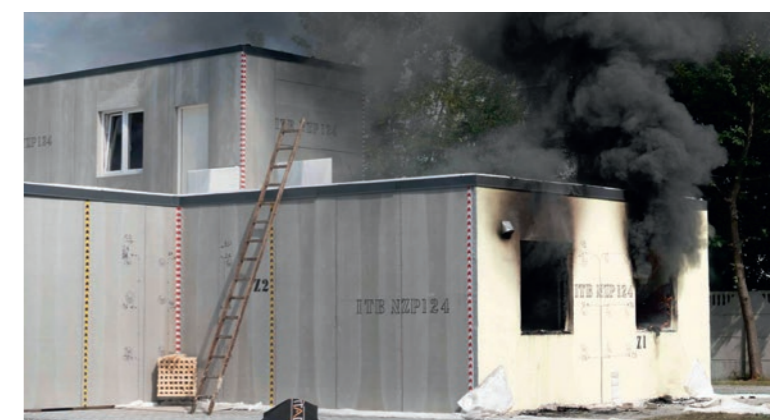
Fot. 8. Widok budynku po przeprowadzonym eksperymencie P2
