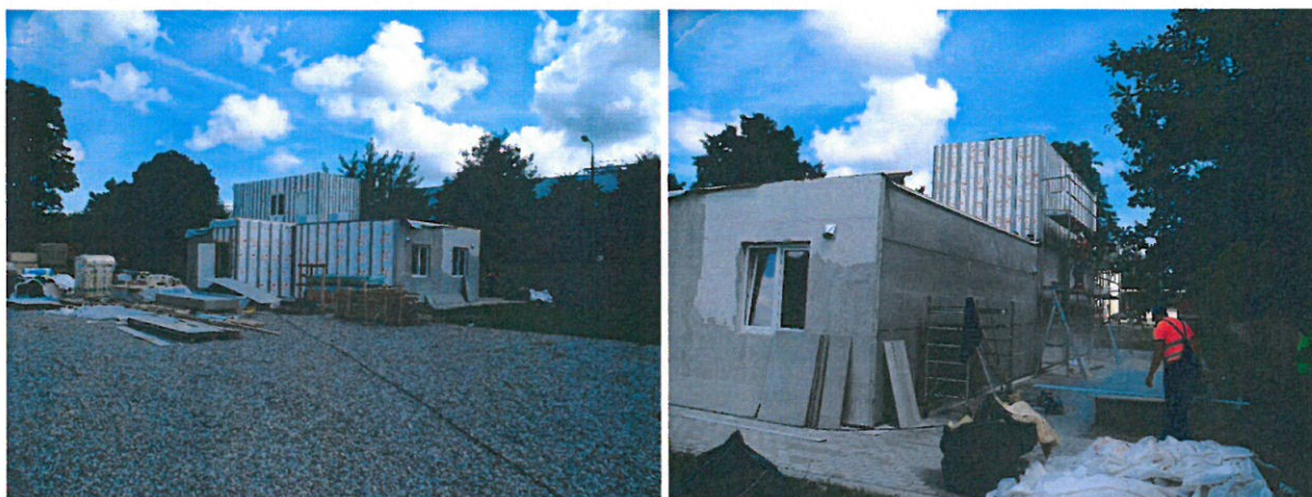
Rys. 7. Prace wykończeniowe w budynku – elewacje
