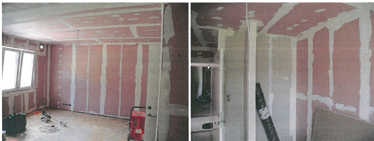
Rys. 8. Prace wykończeniowe w budynku – wnętrze budynku
