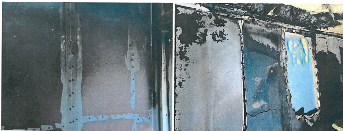
Rys. 17. Sekcja pomieszczenia po pożarze wg scenariusza P3.
