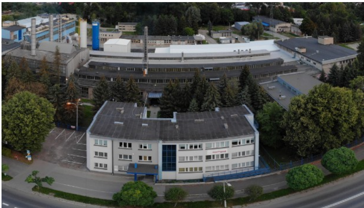
Zakład Saint-Gobain w Gorlicach. Fot. Adfors
